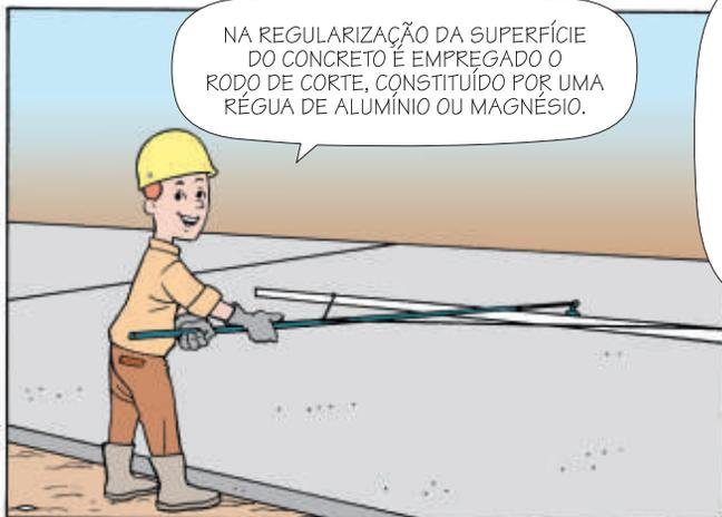
O RODO DE CORTE DEVE SER APLICADO NO SENTIDO TRANSVERSAL ALGUM TEMPO APÓS A CONCRETAGEM, QUANDO O MATERIAL ESTIVER UM POUCO MAIS RÍGIDO. SEU USO IRÁ REDUZIR CONSIDERAVELMENTE AS ONDULAÇÕES QUE A RÉGUA VIBRATÓRIA PODERÁ DEIXAR.
