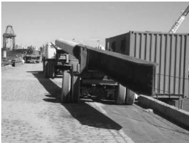
Fotografia 1 - Estaca mista (concreto-perfil metálico) para atravessar solos resistentes sem risco de levantamento de estacas já cravadas. Também se utilizam em obras marítimas conforme se mostra nas provas de carga números I.19 e I.41.
