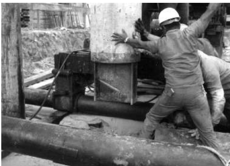
Fotografia 2 - Estaca mista (concreto-perfil metálico) para apoio em rocha
