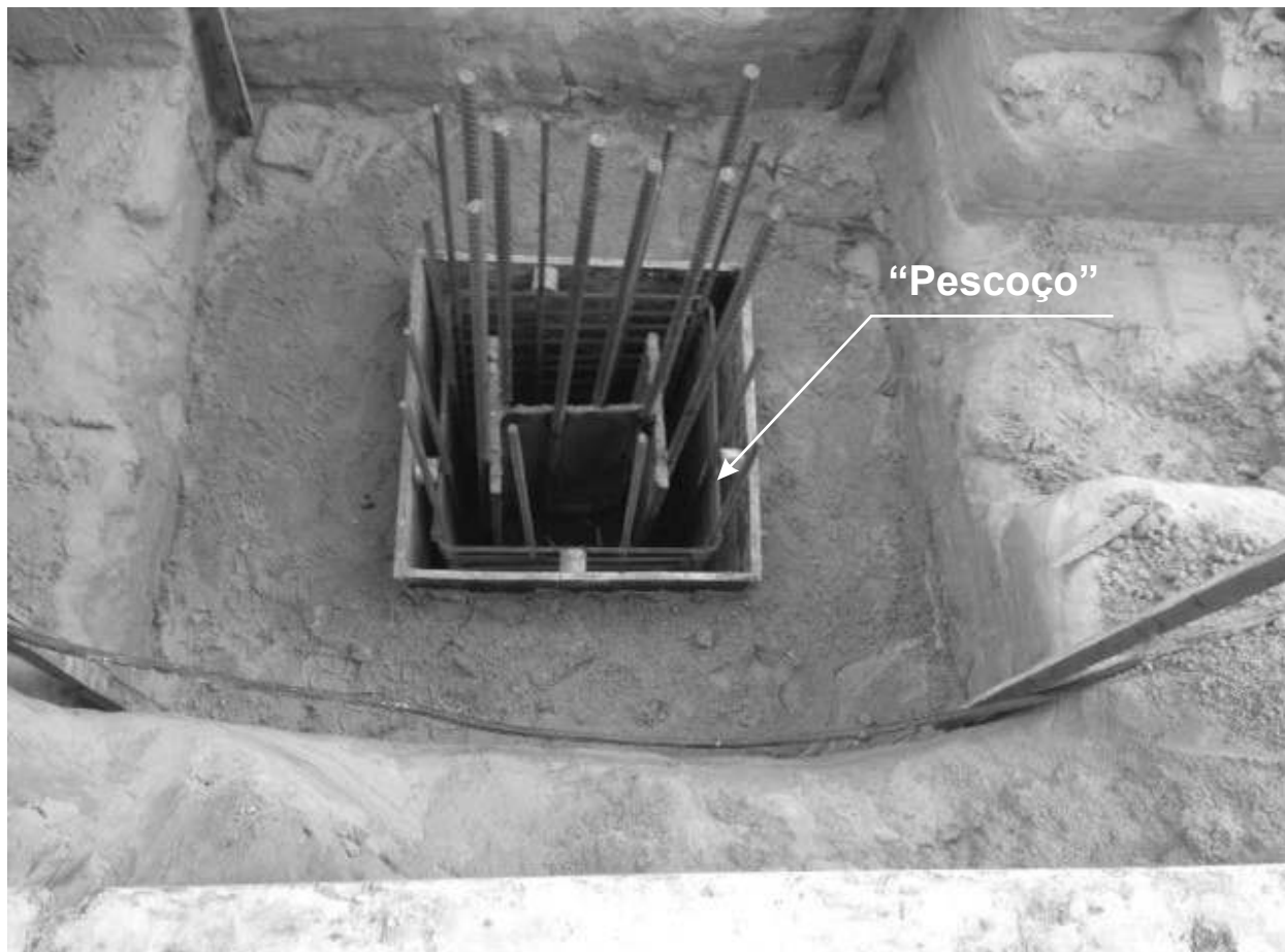
Fotografia 5: Vista da ligação estaca metálica – bloco conforme detalhe da Figura 10
