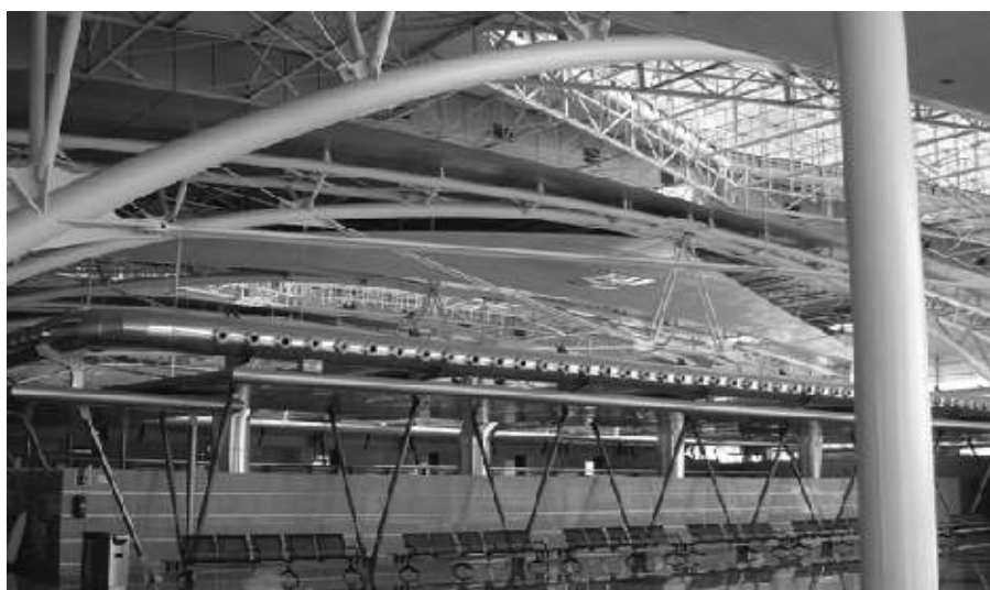
Figura 55: Estrutura protegida por tinta intumescente.
