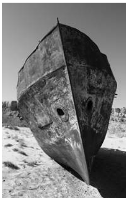
Figura 8: A corrosão atmosférica é a mais comum e importante forma de corrosão.
