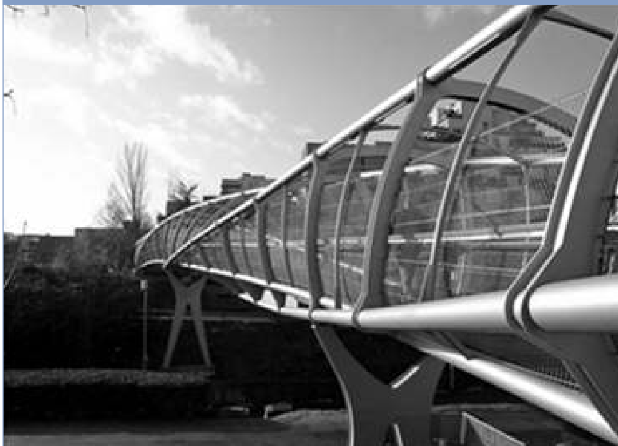
Figura 23: Tubos devem ser impermeáveis ao ar e à umidade. Passarela de pedestres em Évry, França.
