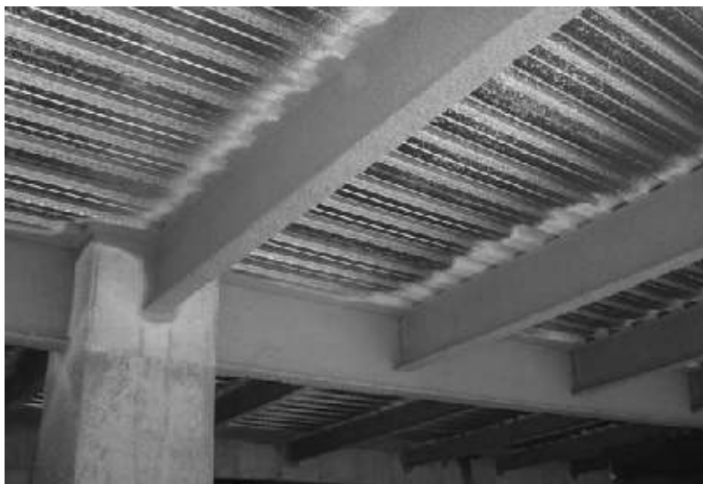
Figura 53: Vigas protegidas por argamassa projetada.
