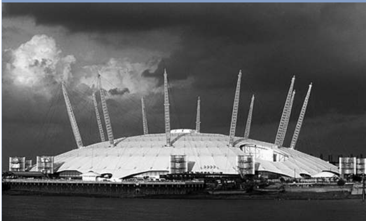
Figura 59: O centro de exposições “Millenium Dome”, em Londres (1999). Este é um exemplo de edificação tornado possível pelo uso da engenharia de segurança contra incêndio.
