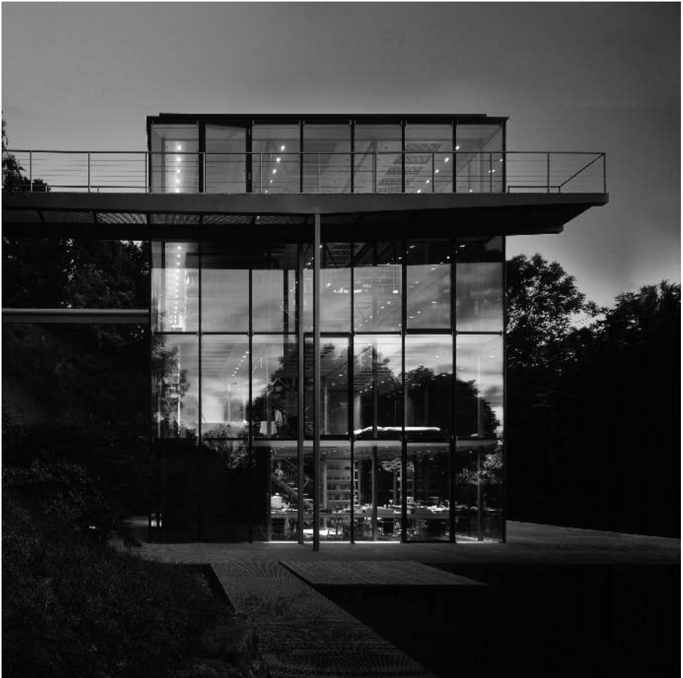
figura 1_vista lateral com ponte de acesso
