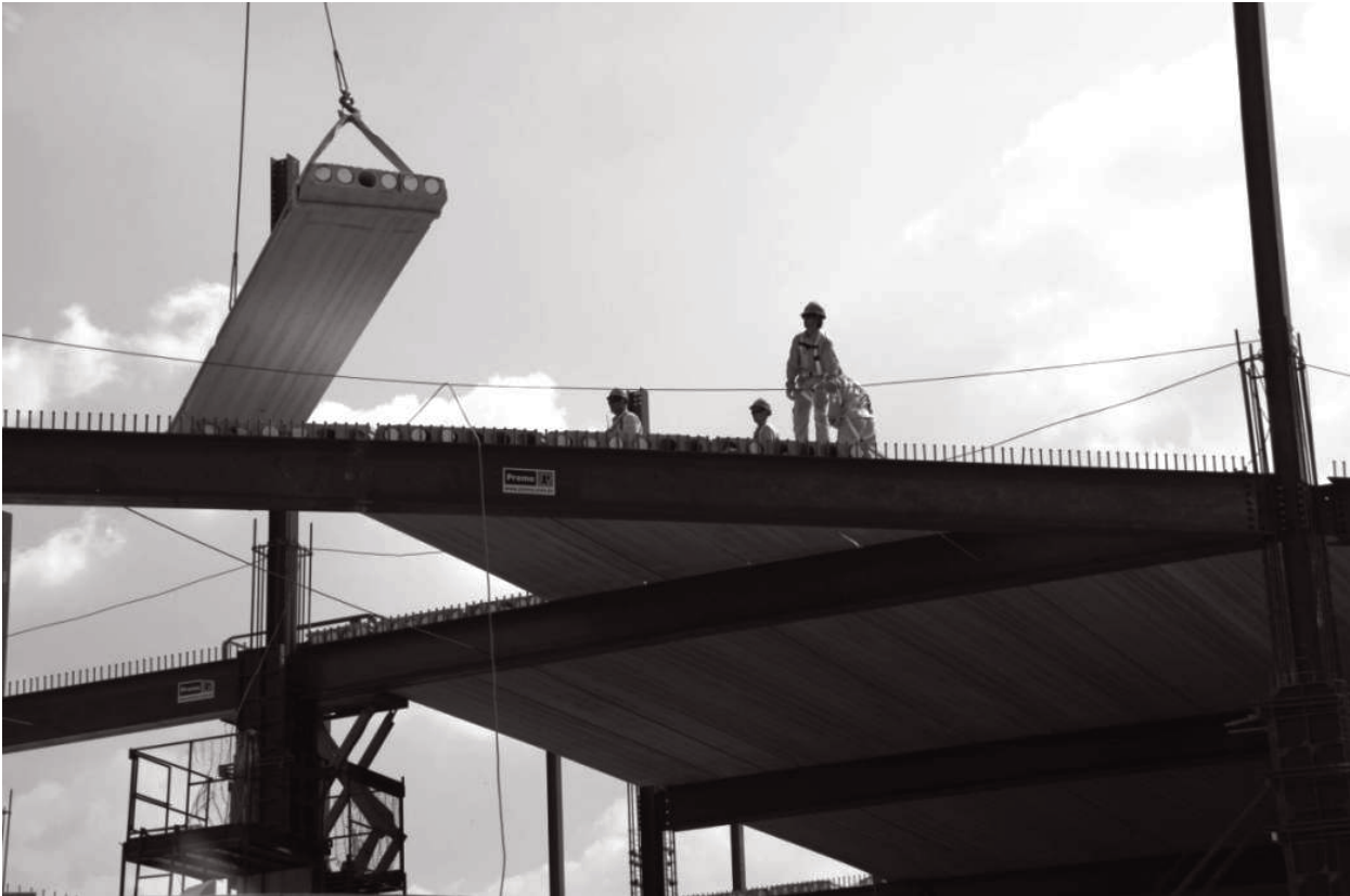
Foto 2.3 - Montagem de lajes alveolares
