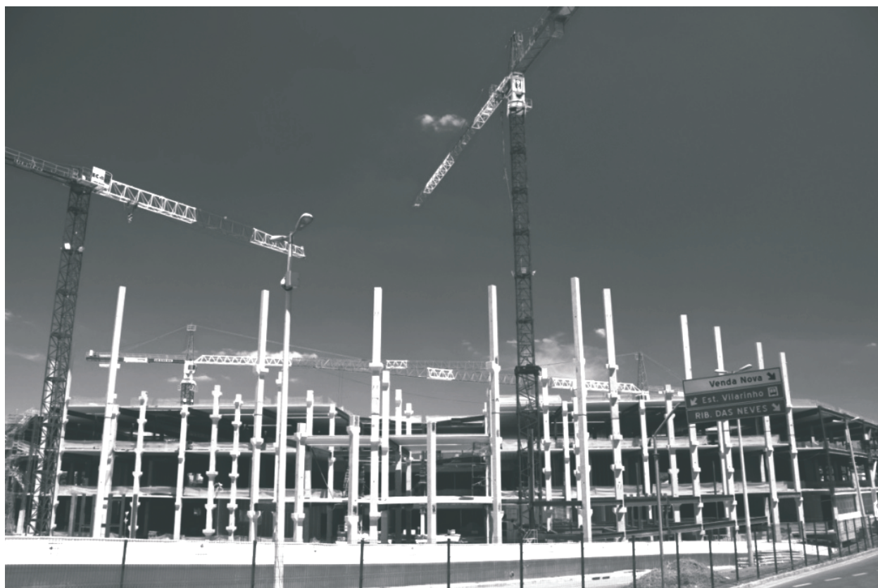
Foto 2.2 - Montagem do Shopping Estação BH, com utilização de guias. Ampliação vertical sobre estação de integração de ônibus-metrô que já estava em funcionamento.
