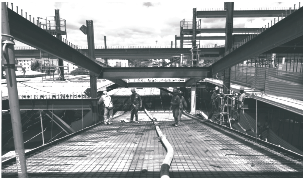
Foto 2.4 - Detalhe de armação de capeamento em sistema misto de aço e lajes alveolares
