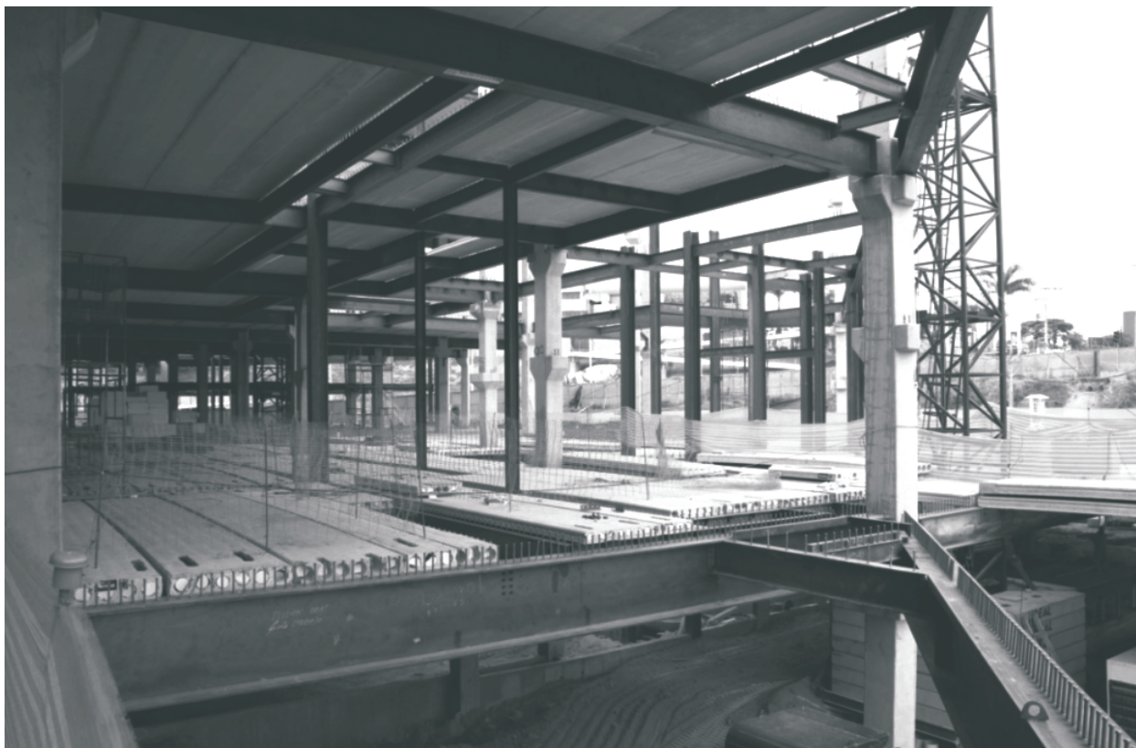
Foto 2.1 - Interface entre vigas de aço e pilares pré-fabricados de concreto
