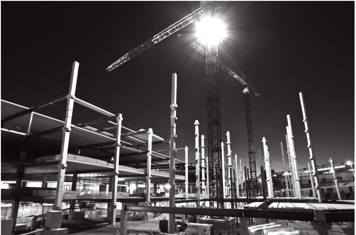
Fotografia 5.8 - Sistema misto de vigas de aço e lajes alveolares
