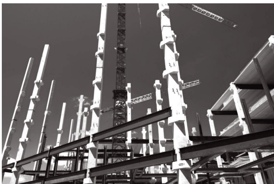
Fotografia 5.1 – Montagem das vigas de aço nos chumbadores dos consolos
